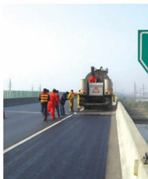
2009年12月，上海A30应用施工
