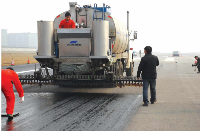
2010年12月，陕西汉中机场应用施工
