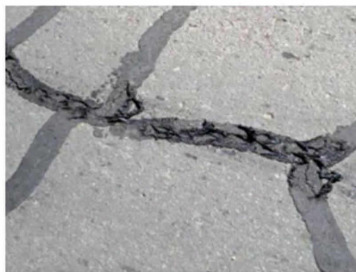
劣质灌缝胶被车轮卷走
