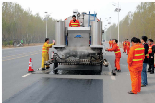
2009年5月，107国道河南新乡段应用施工
