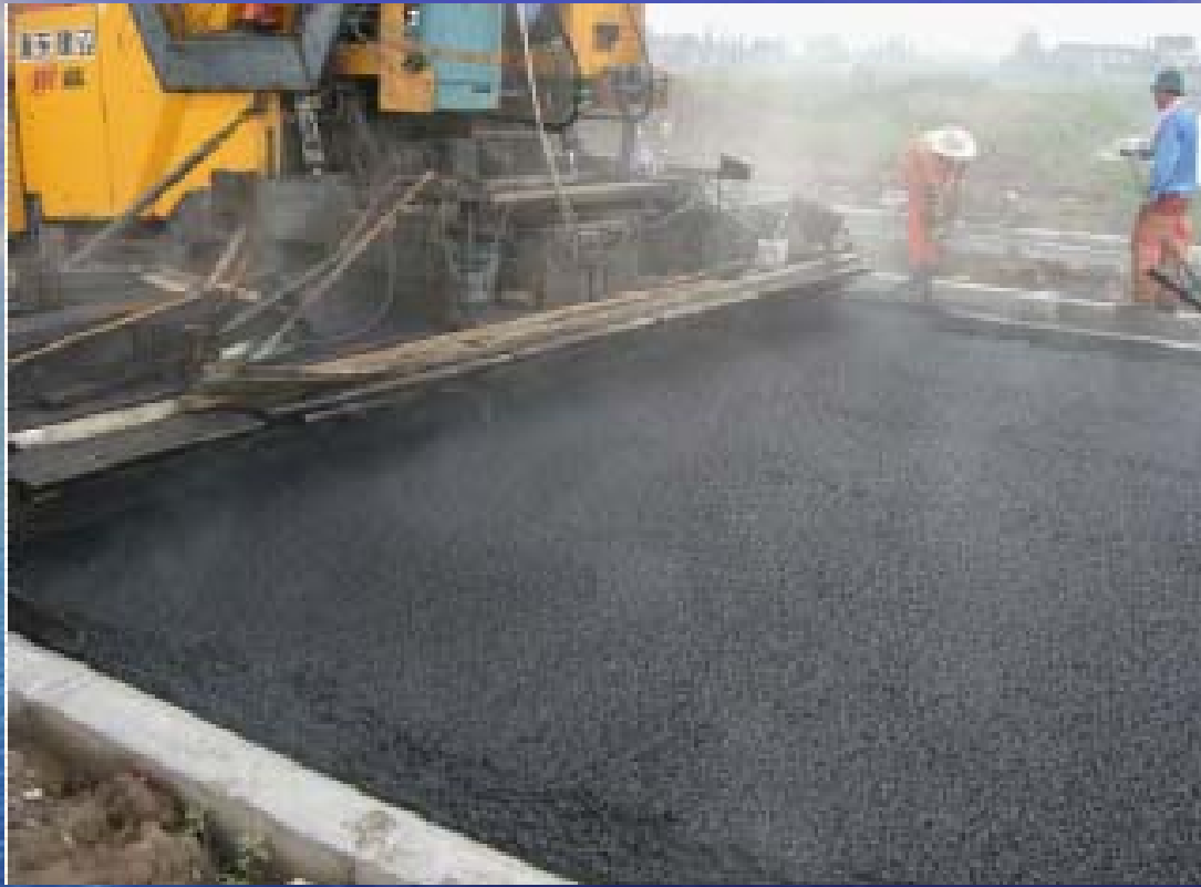
2006年上海浦东高科东路橡胶沥青SMA摊铺现场
